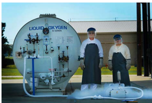
FIGURE 1.4 – À gauche : lorsqu’il est comprimé dans un compresseur, l’air perd de la chaleur au travers des parois et des aubes des cylindres ; et pourtant sa température augmente. À droite : à l’inverse, lorsqu’il est détendu dans une soupape, l’oxygène liquide reçoit de la chaleur de l’atmosphère (comme le mettent en évidence la condensation et le gel de l’eau atmosphérique sur les tuyaux) ; et pourtant sa température chute.
